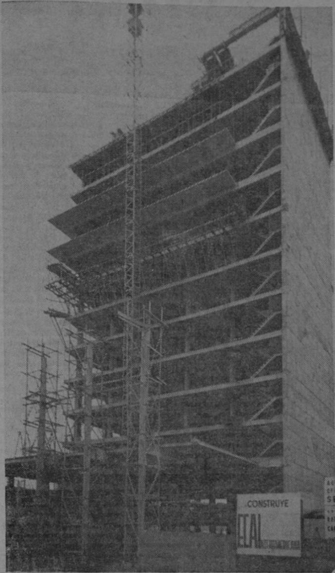
Estructura del edificio de la Caja, en la manzana del antiguo Museo. 14 pisos arriba y 2 de sótano. Todo forrado en mármoles traídos de Italia.
